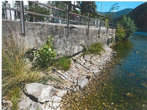
**Fotografie 2+3:** Muro di sostegno all'imbocco dello Stretto di Lavena con le erosioni al piede dovute all'effetto del lago con l'azione continua del moto ondoso.
