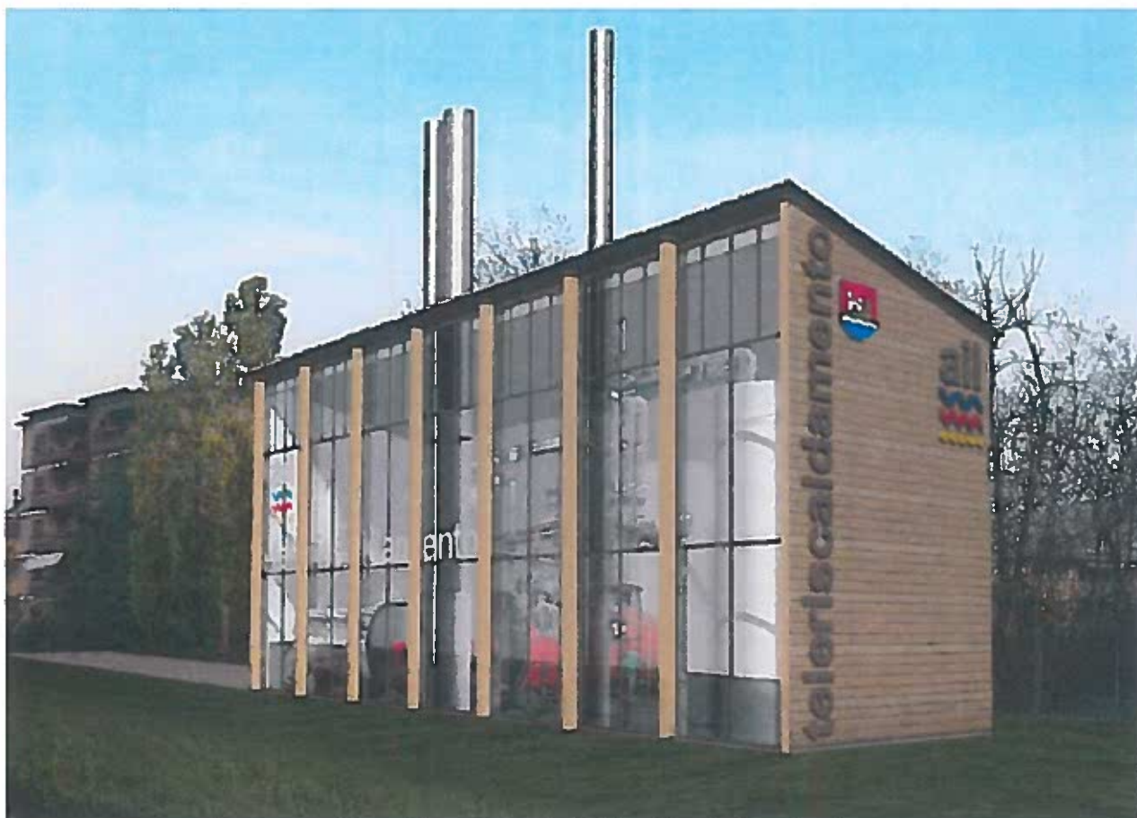
Foto della nuova centrale vista dalla strada cantonale.
