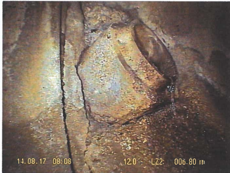
Foto 4 e 5: Allacciamenti e camera con volta in mattoni (Ispezione con telecamera – ISS; 14.08.2017).
