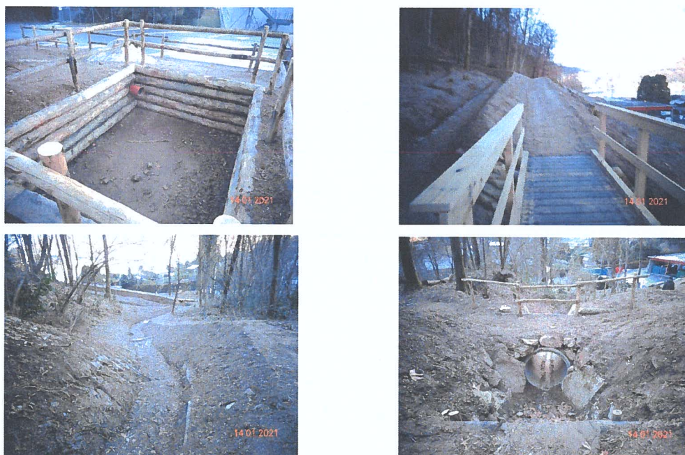
Figura 18: Fotografie lavori eseguiti Area 4 Zona Ecocentro
