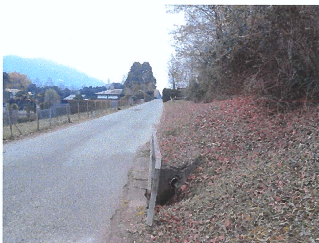
Figura 30: A sinistra il canale naturale verso il lago a valle di Via Torrazza, a destra lo scarico delle caditoie stradali e il ciglio dove sarà eseguito un canale a cielo aperto
