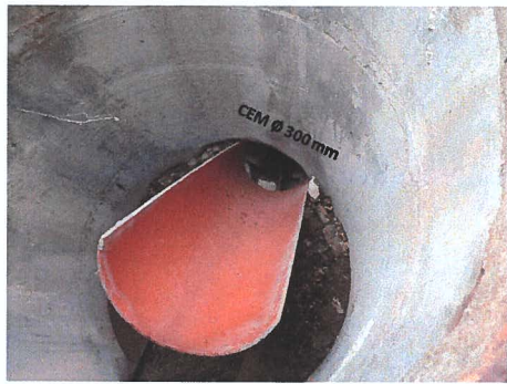
Figura 124. dettaglio uscita canalizzazione acque meteoriche dal pozzetto M2.1.
