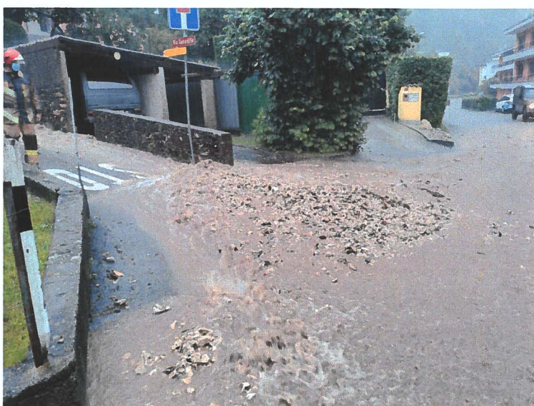
Figura 4 e 5: Materiale portato dalle acque lungo la Via Sassalto fino a Via Torrazza a seguito delle importanti precipitazioni del 7.6.2020
