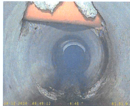
M15c - M127_0007.jpeg, 00:06:43, 61.51m Nota generale, Tubo PVC passante / Tubo PVC passante
