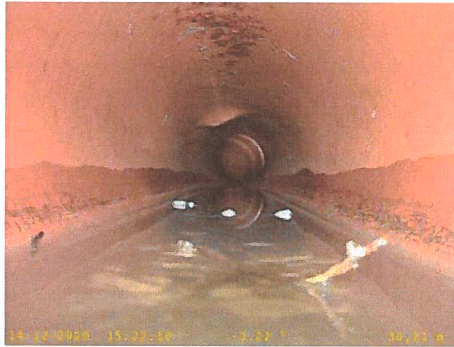
M3_1 - M4_1_0005.jpeg, 00:04:58, 36.21m Livello dell'acqua: Acqua di scarico è chiara (fondo visibile), 20% dell'altezza netta
