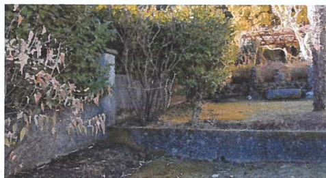
Figura 23: Muro a confine all'interno della particella n.401, dove potrebbe essere eseguito il canale a cielo aperto
