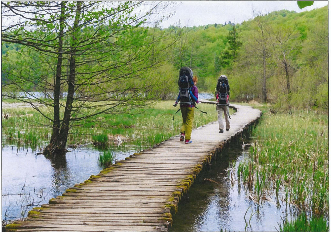
Figura 12: esempio di passerella pedonale sul lago presso i laghi di Plitvice, Croazia.
