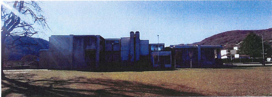
Figura 4 – Vista Facciata EST
