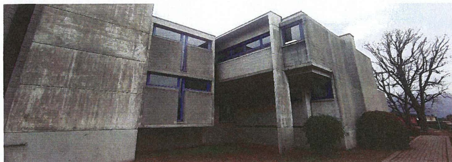
Figura 7 – Vista Facciata OVEST
