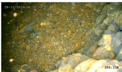
La funzionalità del pozzo a medio-lungo termine è probabilmente compromessa dalla presenza di incrostazioni dure sulle pareti filtranti del pozzo. La parete del pozzo è puntualmente danneggiata.
