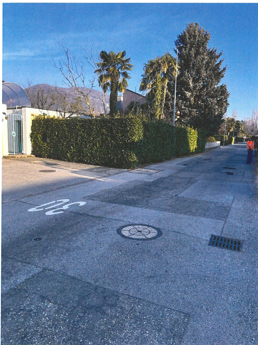
Figura 3 - Tratto stradale in prossimità dell'imbocco da via Stazione: individuazione di rappezzi.
