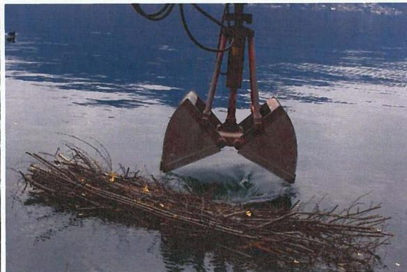
Figura 6. Posa di fascinate di ramaglie, zavorrate (progetto CSD Ingegneri, riqualifica delle rive lago del Comune di Melide)
