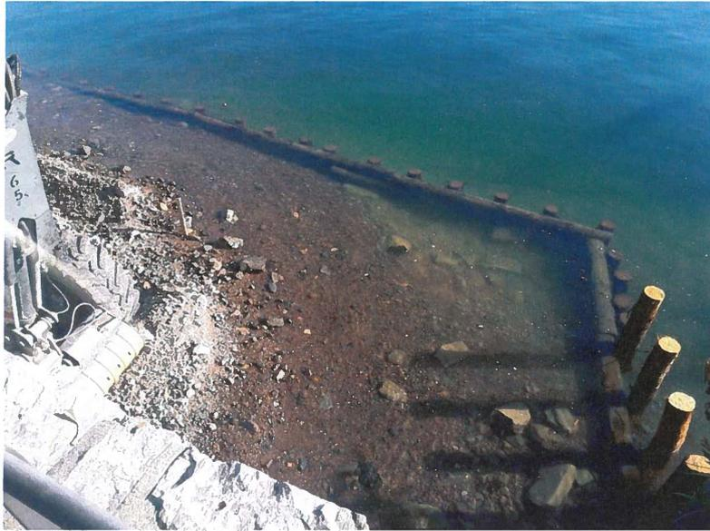
Figura 9. Esempio realizzato di correnti orizzontali posati (progetto CSD Ingegneri, riqualifica delle rive lago del Comune di Melide)
